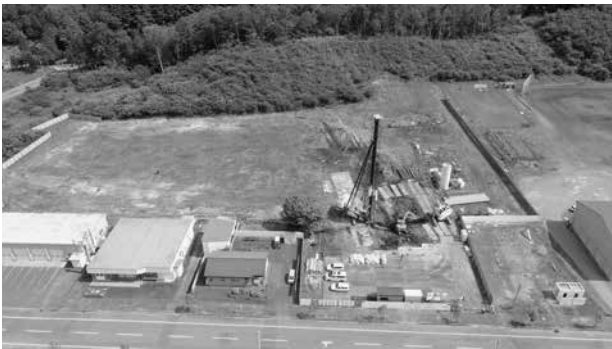
写真3 8月12日の建設現場の様子
