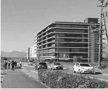
建設中の半導体工場
