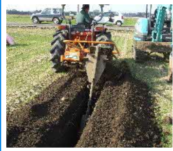
暗渠排水の整備
